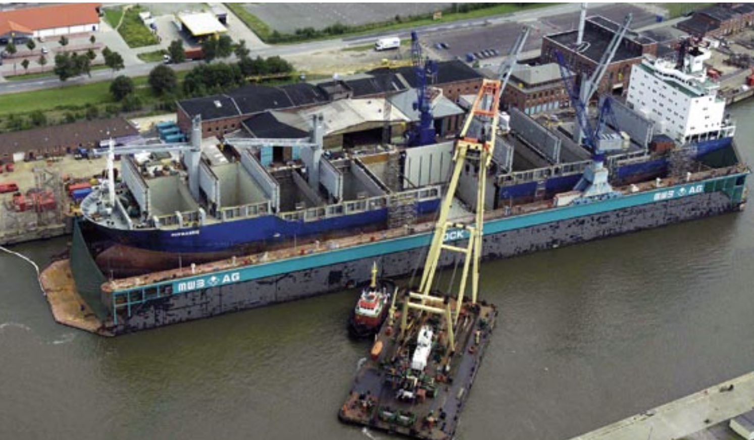
Einsetzen der 600 t-Sektion zur Schiffsverlängerung
