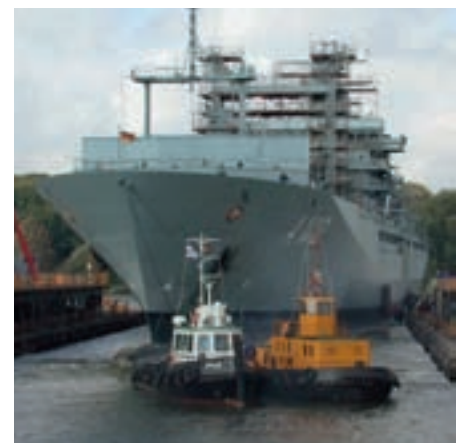
Instandsetzung des Marineschiffes A1412 EGV FRANKFURT AM MAIN
