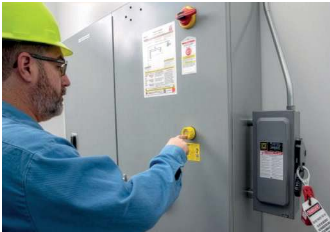
VeriSafe von Panduit verkürzt und erleichtert das Prüfen auf Spannungsfreiheit per Knopfdruck. Das Messmodul wird in elektrischen Anlagen verbaut.
