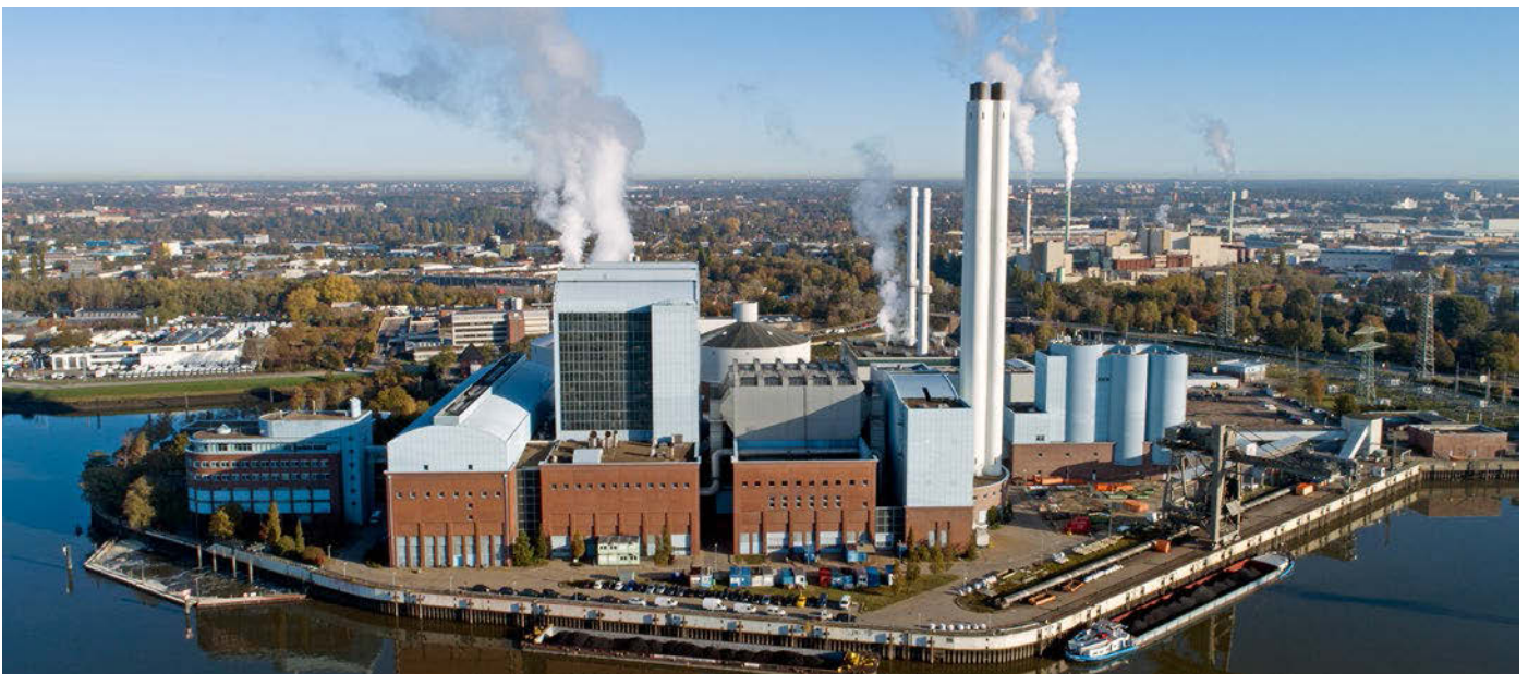
Am Hamburger Kraftwerksstandort Tiefstack sollte der Wärmespeicher realisiert werden; Foto: Wärme Hamburg The heat storage facility was to be realised at the Tiefstack power plant site in Hamburg; Photo: Wärme Hamburg
