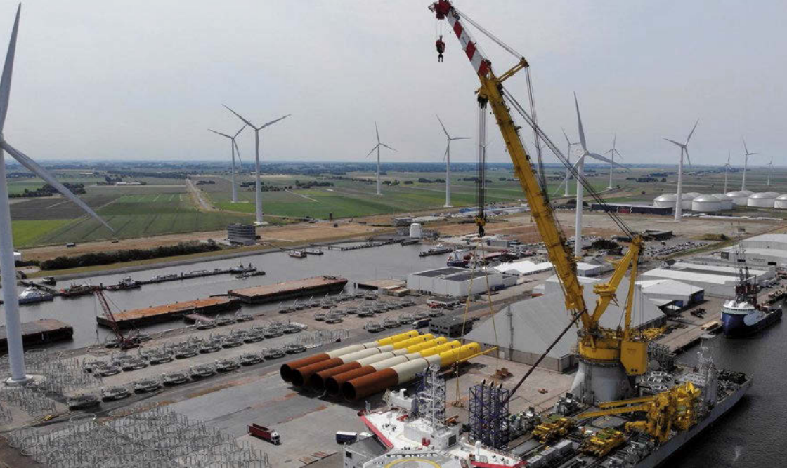
Les Alizés loading monopiles in Eemshaven
